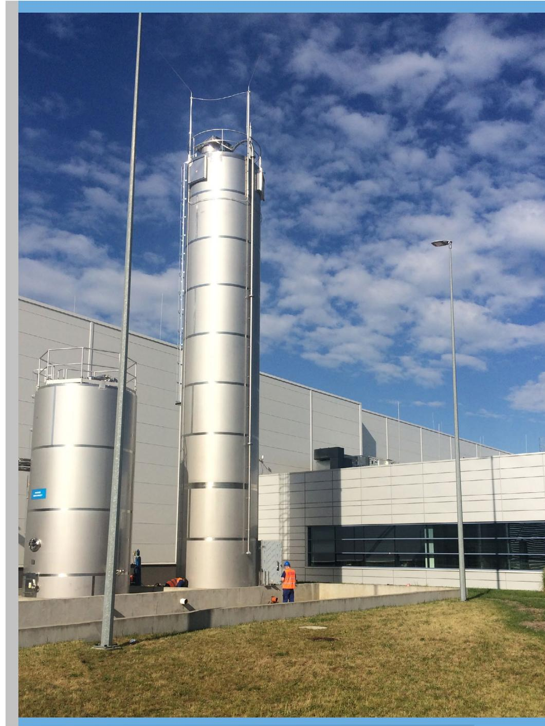
Sehr oft fertigen wir Silos und Tanks in Verbindung mit kompletten Rohstofftransportanlagen an. Wir stellen sowohl freistehende Silos auf eigener Tragstruktur mit Betonfundamenten her, wie auch Silos und Tanks mit einem gemeinsamen Tragrahmen her. Wir bieten ferner umfassende Bauarbeiten im Zusammenhang mit der Anlage neuer Silos an.
